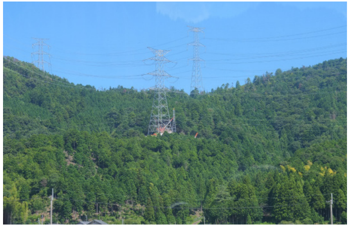
写真2 おおい町と高浜町の境界に立つ鉄塔。重機が見える。
