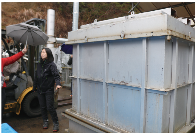
写真3：密閉式ユニット (分離タイプ) の説明の様子
